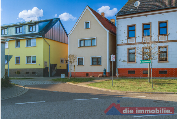
Blick von der Straße
