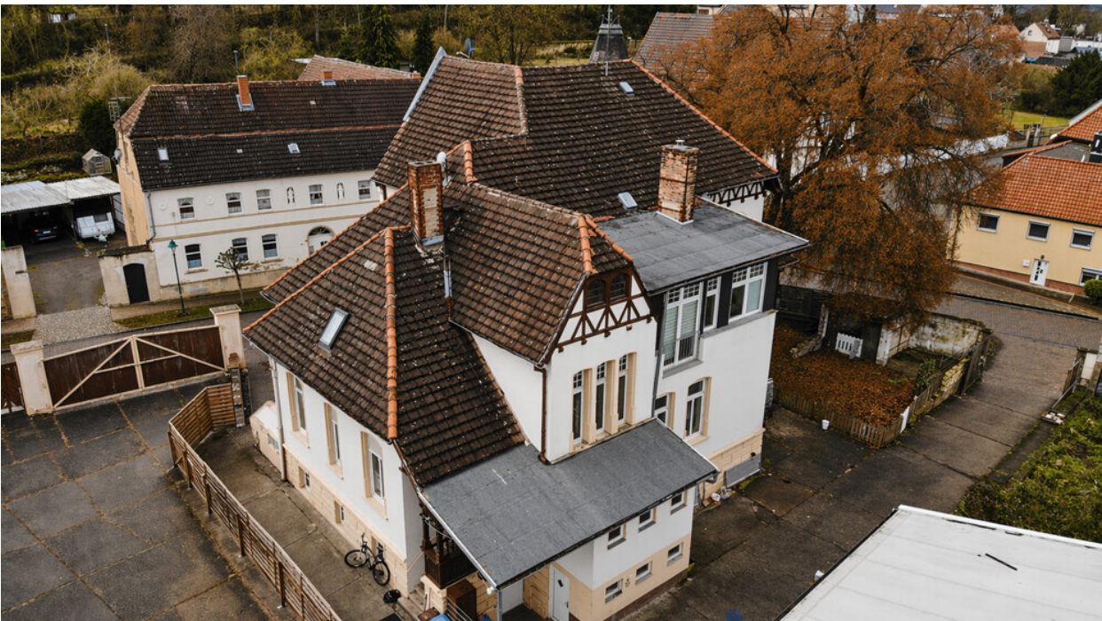
Rückwärtige Ansicht der Villa mit angrenzenden Hof- und Nebenflächen
