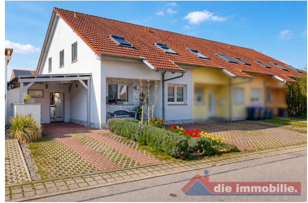
Straßenseitige Ansicht mit Carport und Zugang
