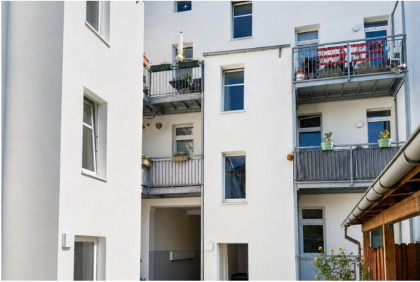
Rückwärtige Gebäudeansicht mit Balkonen
