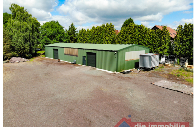
Großzügiger Zufahrtsbereich zur Lagerhalle
