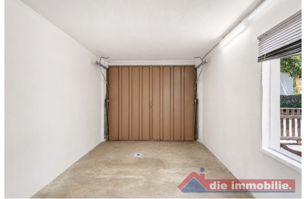
massive Garage mit Tageslicht
