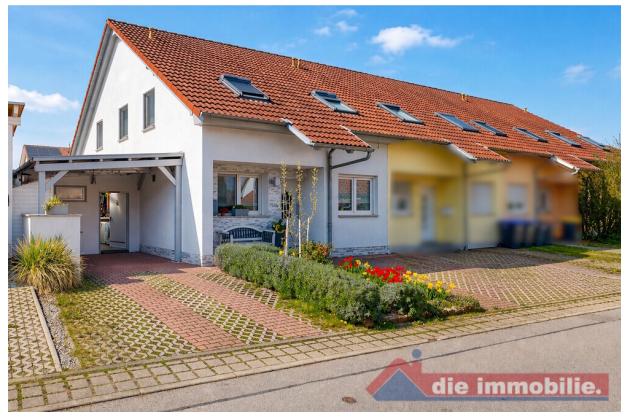
Straßenseitige Ansicht mit Carport und Zugang
